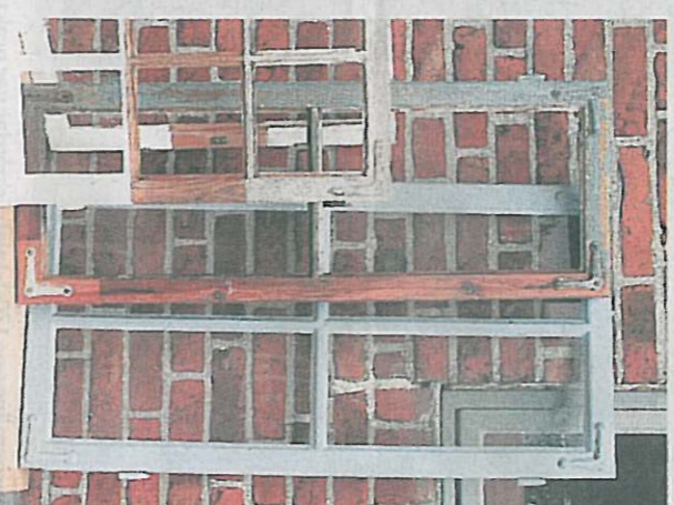
Ett urval gamla fönsterbågar används som undervisningsmaterial på Allbäckskurser.
